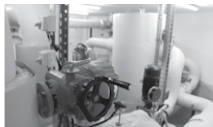
AZ ÚJ, MÁJUS I. ÚTI SZIVATTYÚHÁZ BERENDEZÉSE
