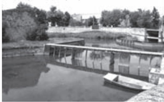
VÁRÁROK, HÁTTÉRBE A SZAKRENDELŐ ÉPÜLETE
