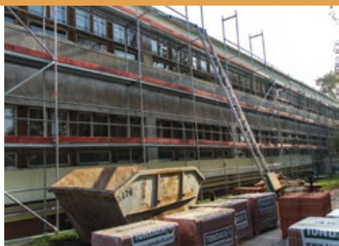
A Jávorka kollégiuma felújítás közben és után
