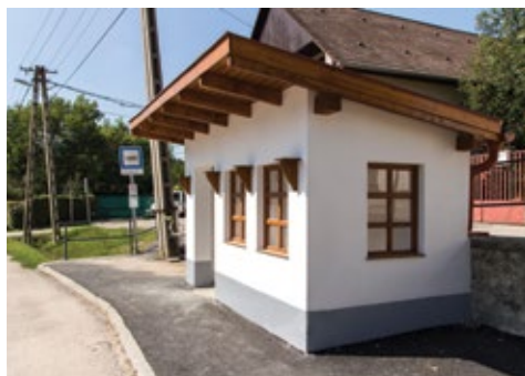
2018 őszén új buszváró épült Agostyánban
