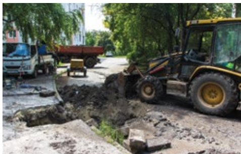
Csapadékvíz-elvezető cső tisztítása a Május 1. úton
