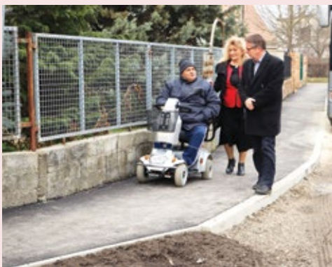
Új járdaszakasz a Dadi úton
