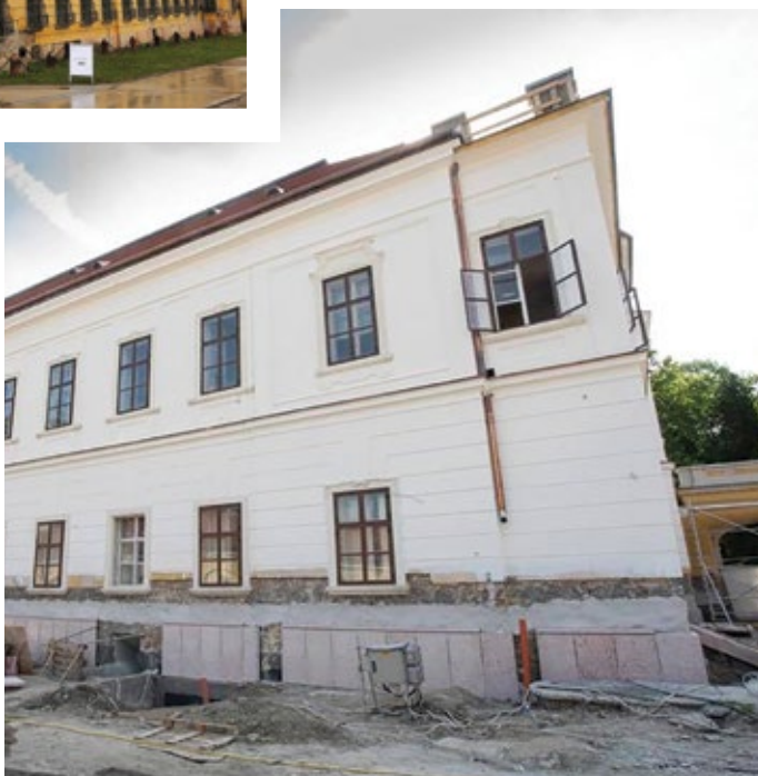
A kastély a felújítás alatt
