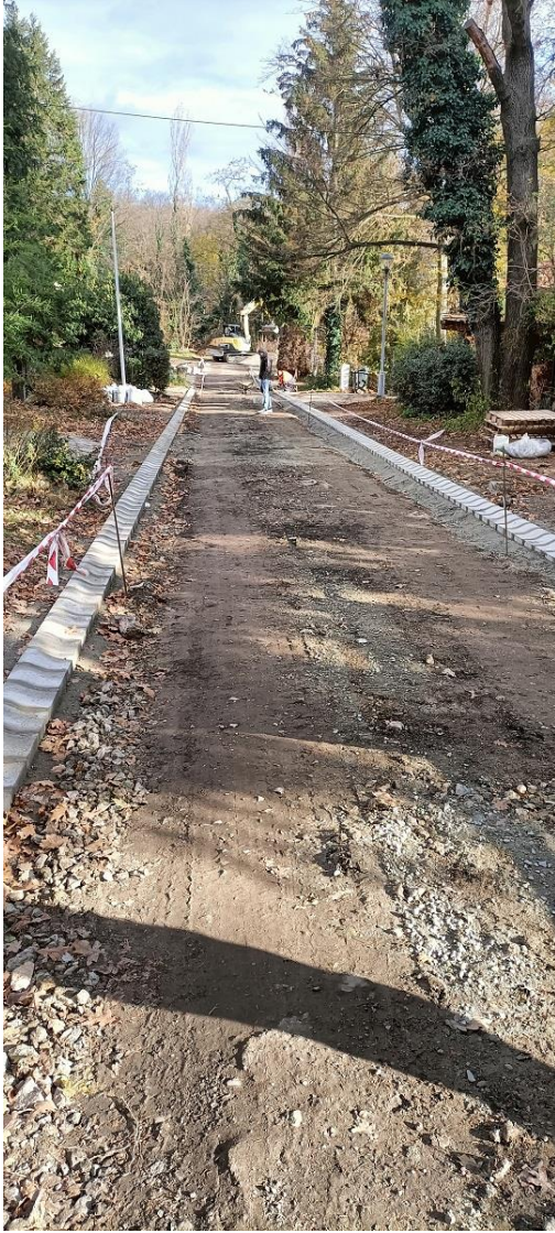
A Mária és Judit utca szegélyezése megtörtént. Az árok kiépítéshez a növényzet kiírása folyik.
