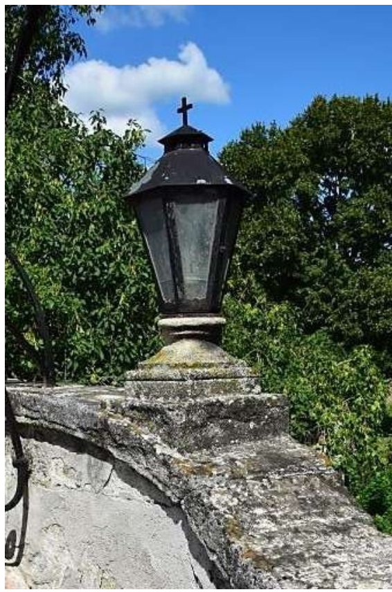
Plasztikai hiányok, hiányzó fuga, szennyezett felület.
