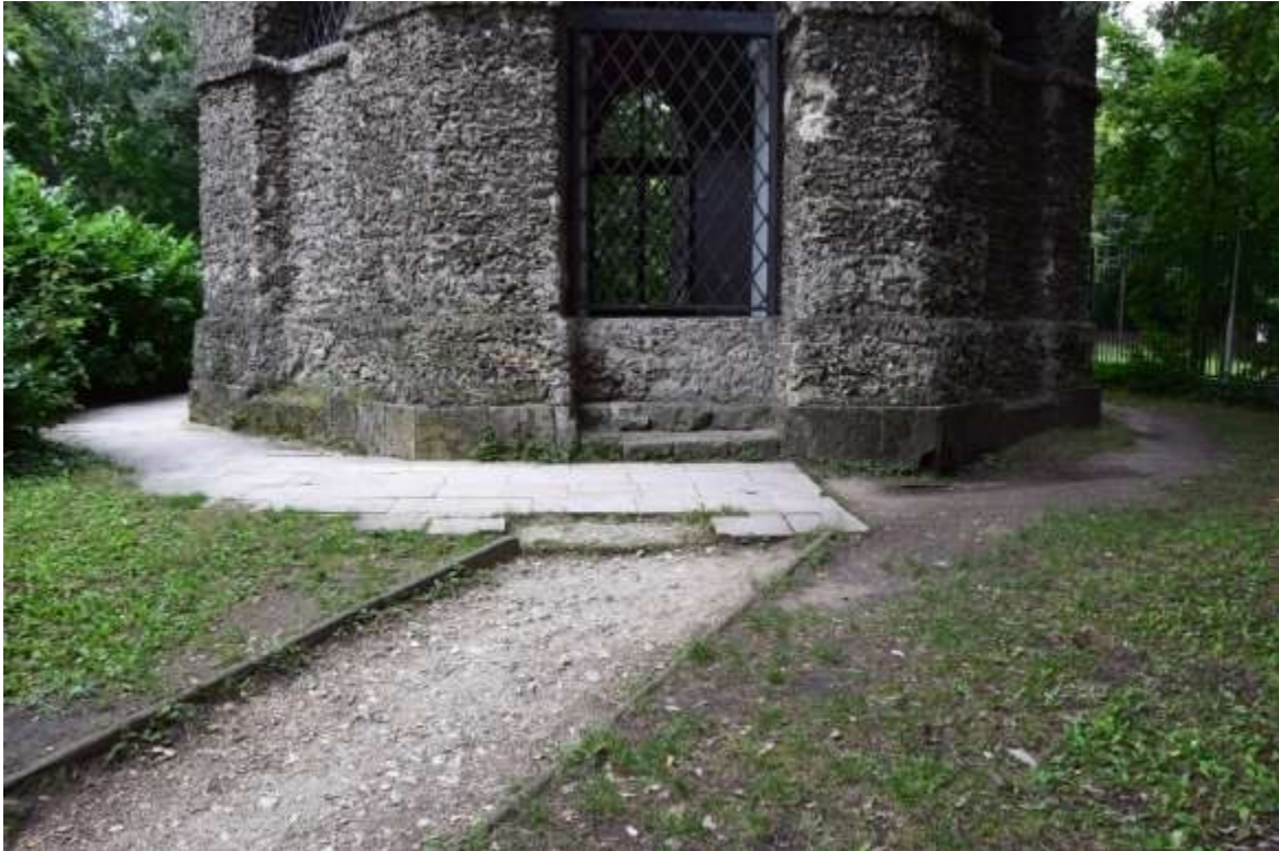
Félig burkolt, körbeburkolt épület. A burkolt oldal nedvesebb, mint a szabadon hagyott oldal.
