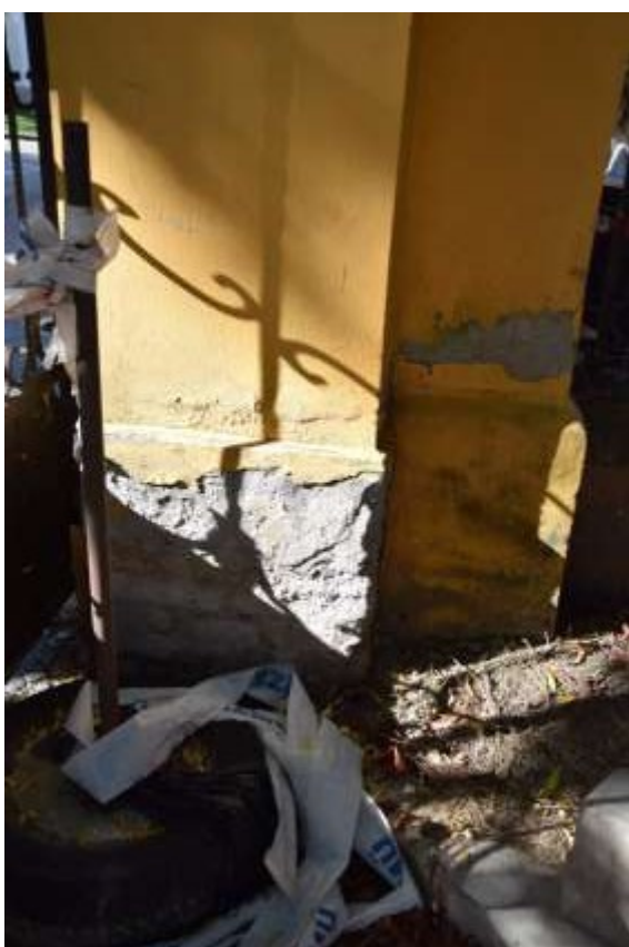
Felvált festékréteg a nedvesedéstől, málló vakolat Bal oldali pillér
