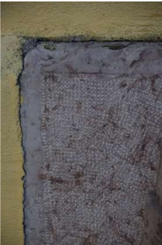
Plasztikai hiányok, friss stokkalás a kerékvetőn Bal oldali pillér
