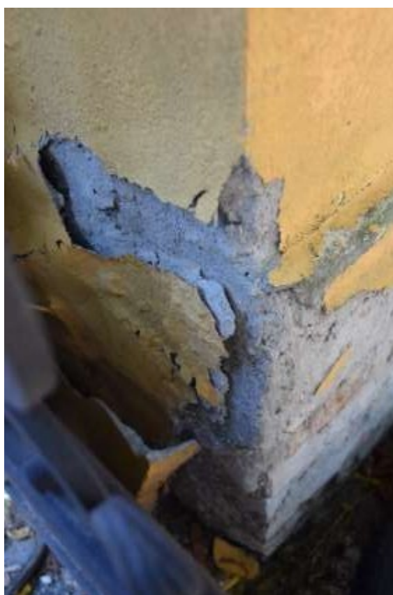
Felvált festékréteg a nedvesedéstől, málló vakolat Bal oldali pillér
