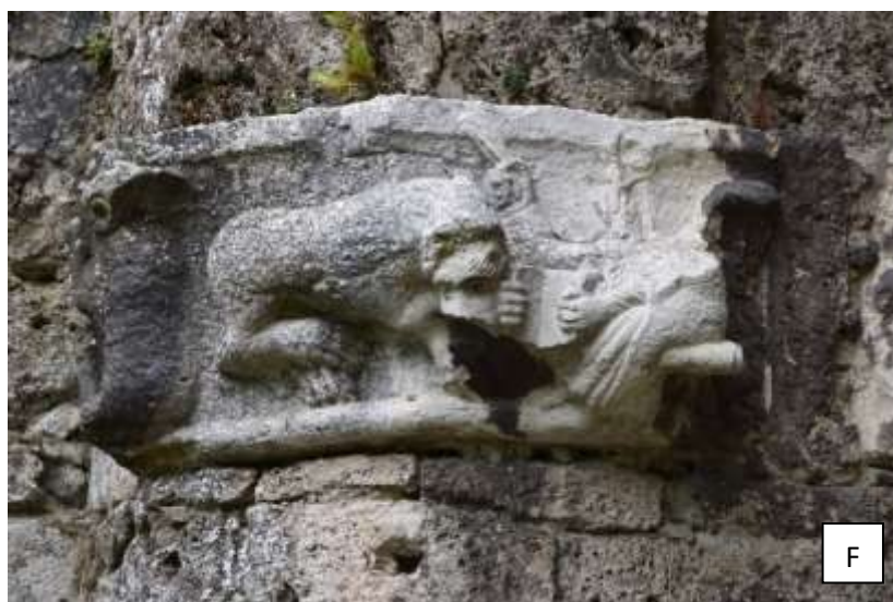
Szennyezett felületek, málló kőelemek és plasztikai hiányok
