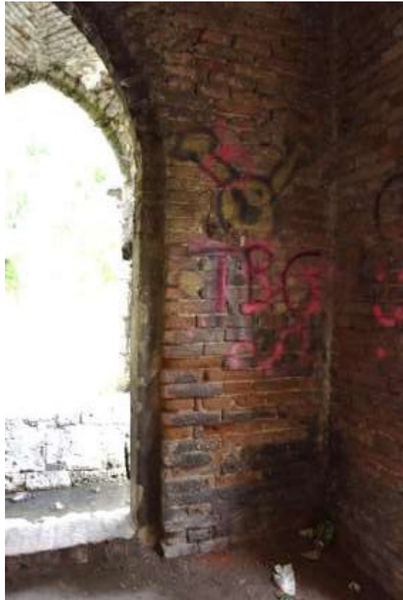
A belső tér téglafalazata nagyon rossz állapotú. Itt megfigyelhetők a sók roncsoló hatása, a málló fugák, hiányzó téglaelemek, korom, graffiti és szemét.
