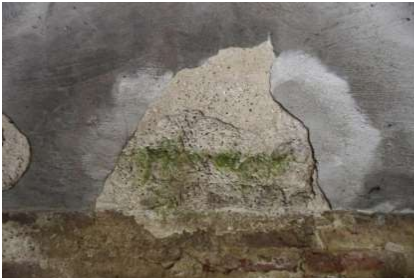
Meszes vakolatra felkent 2-3 mm es cementes réteg
