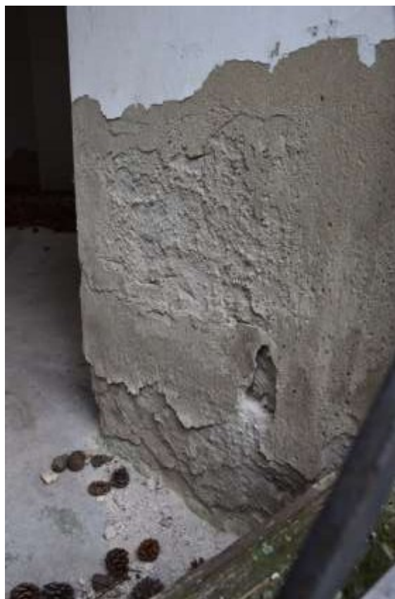
Málló, kérgesen leváló vakolat a beltérben.
