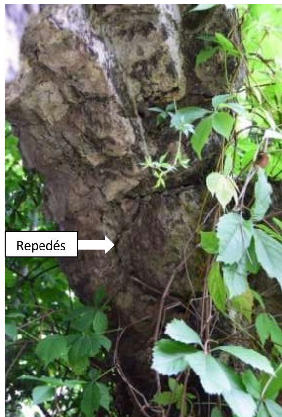
Repedés a rakott kőfal ívén. A repedést a folyamatosan erősödő növényzet gyökérzete is súlyosbítja. (bővebben: Műemlékdiagnosztikai statikai szakértői szakvélemény)
