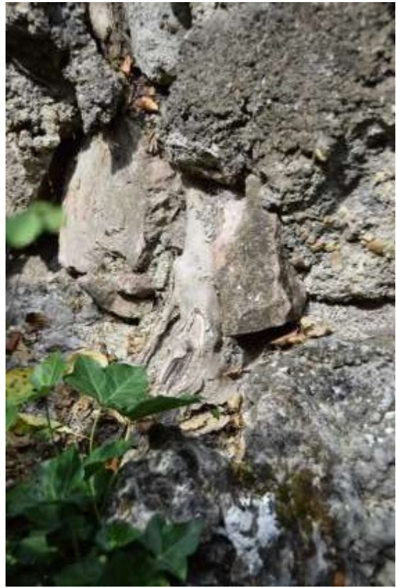
Griff (G2): Tégla és betonmag
