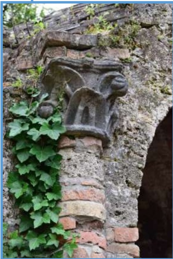
Szennyezett felületek és plasztikai hiányok a falazaton és a domborművön
