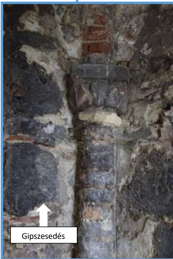
Elszürkült gipszesedett felületek a mészköveken és a fejezeteken
