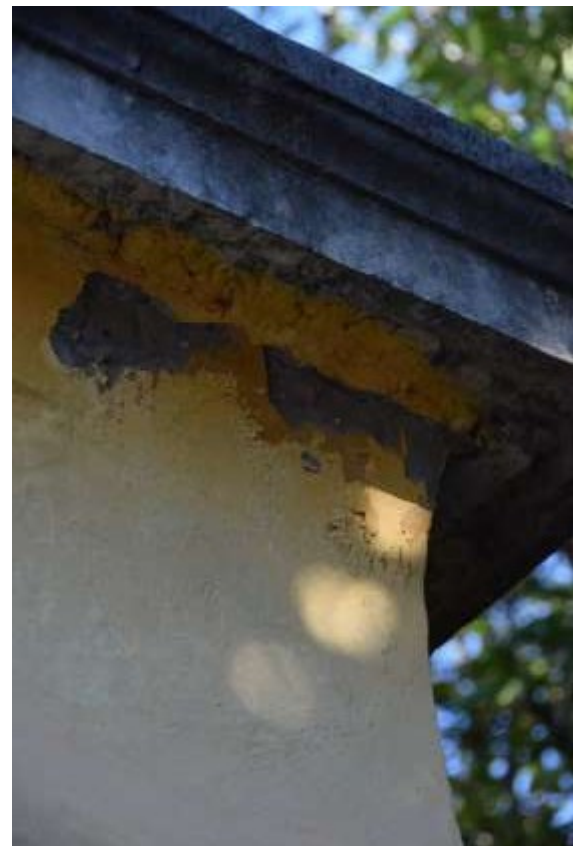
Felvált festékréteg a nedvesedéstől, málló vakolat
