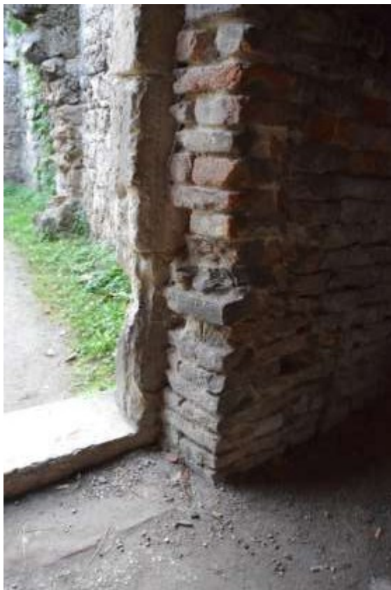
A belső tér téglafalazata nagyon rossz állapotú. Itt megfigyelhetők a sók roncsoló hatása, a málló fugák, hiányzó téglaelemek, korom, graffiti és szemét.
