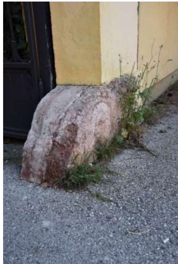
Ülepedés mentén kialakult repedések, nagy hiányok a kerékvetőkön
