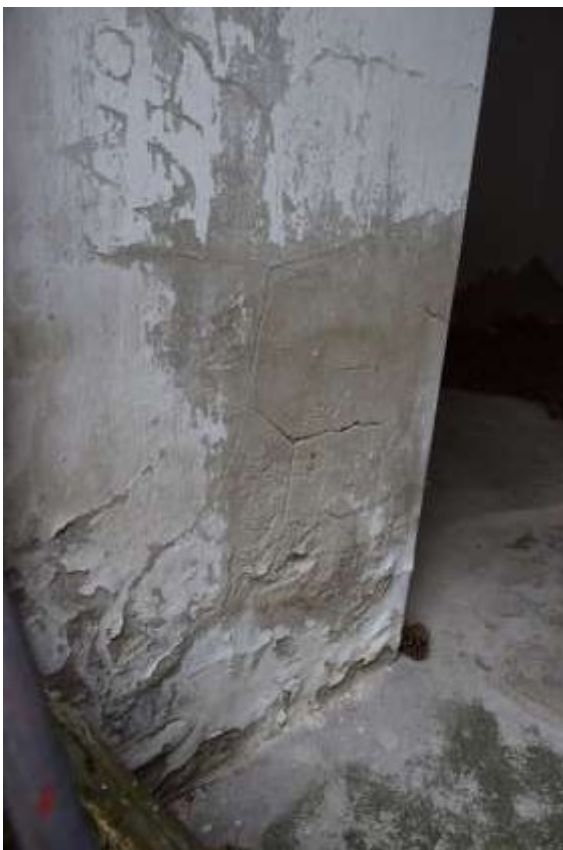
Málló, kérgesen leváló vakolat a beltérben.
