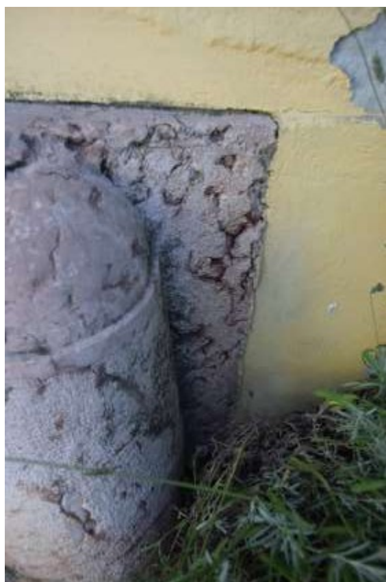
Üledés mentén kialakult repedések, nagy hiányok a kerékvetőkön Jobb oldali pillér
