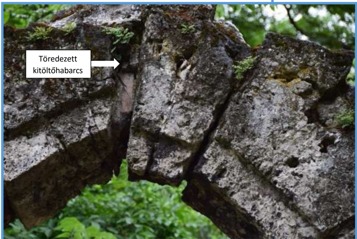
Hiányzó fugák. Ezek pótlása szükséges, hogy a kőelemek stabilak maradjanak és védjék a falazó habarcs állékonyságát és így a boltív állékonyságát. (bővebben: Műemlékdiagnosztikai statikai szakértői szakvélemény)
