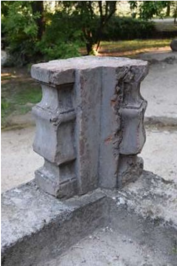
Jó megtartású tömött mészkő korlátelemegek plasztikai hiányokkal
