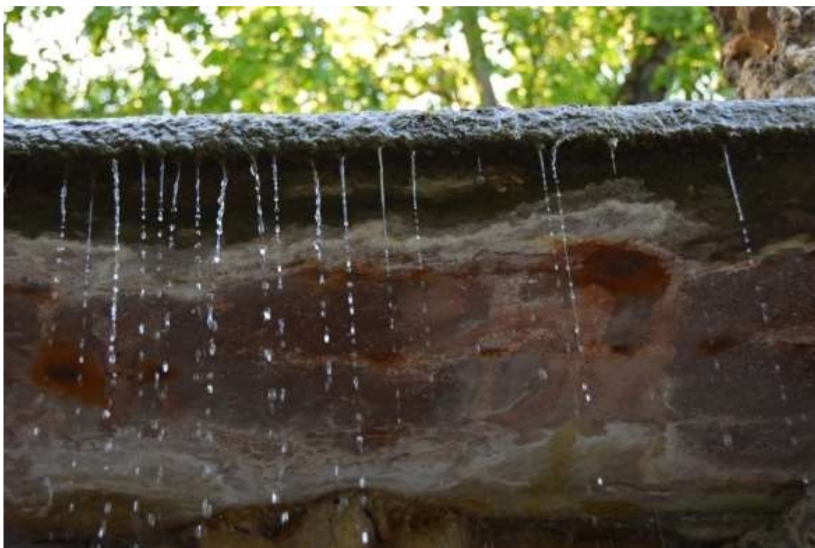
Rozsdásodó vasalat és rozsdafoltok a műkőben. A kilépőlap cseréje szükséges.
