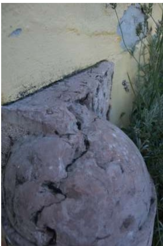
Üledés mentén kialakult repedések, nagy hiányok a kerékvetőkön Jobb oldali pillér
