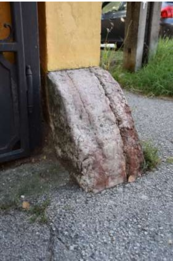
Ülepedés mentén kialakult repedések, nagy hiányok a kerékvetőkön
