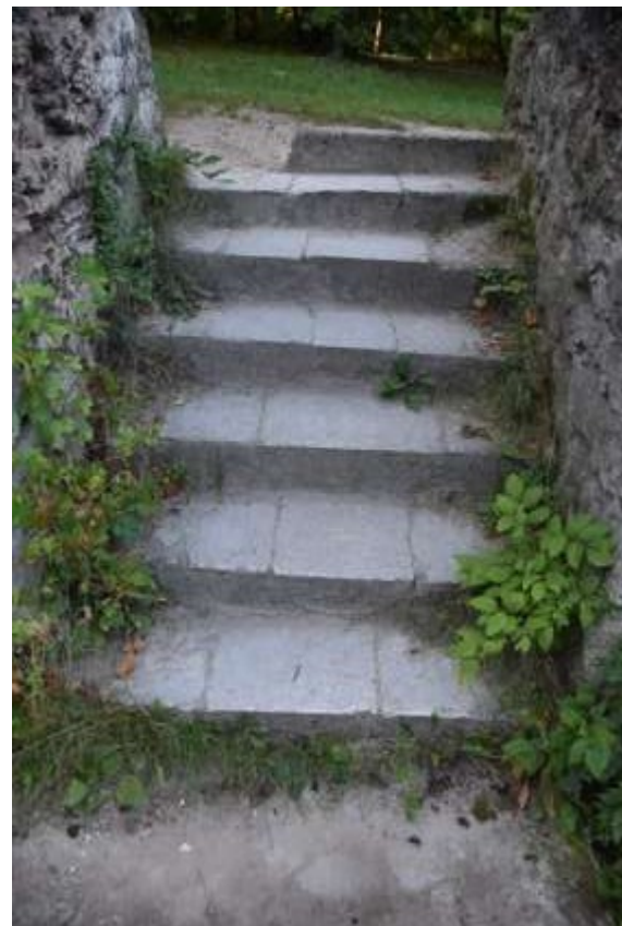
Kimozdult lépcsőfokok, hiányzó fuga, kőhiányok
