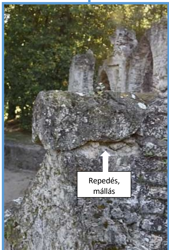
Körebepedt oromzati dísz, balesetveszélyes
