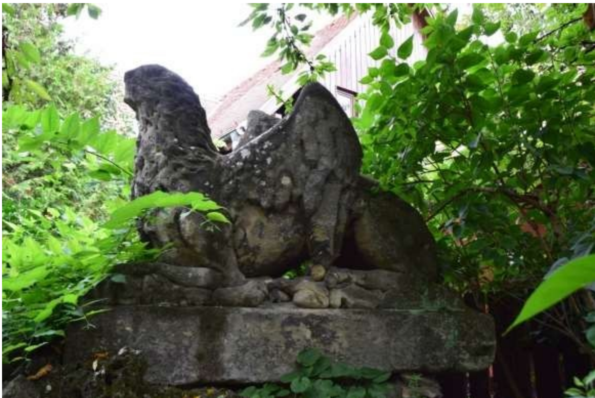
Griff (G2): Biológiai károsítók, szennyezett felületek, griff egész csőre hiányzik
