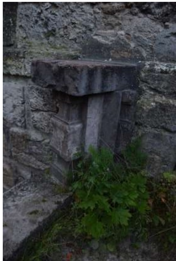
Jó megtartású tömött mészkő korlátelemegek plasztikai hiányokkal
