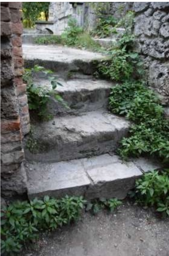
Kimozdult lépcsőfokok, hiányzó fuga, kőhiányok
