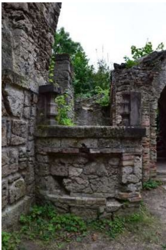
Tömött mészkő korlátelemek, szennyezett felületek, kő és téglahiányok
