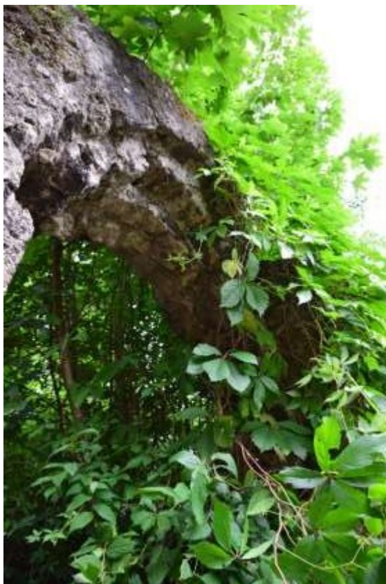
Repedés a rakott kőfal ívén. A repedést a folyamatosan erősödő növényzet gyökérzete is súlyosbítja. (bővebben: Műemlékdiagnosztikai statikai szakértői szakvélemény)
