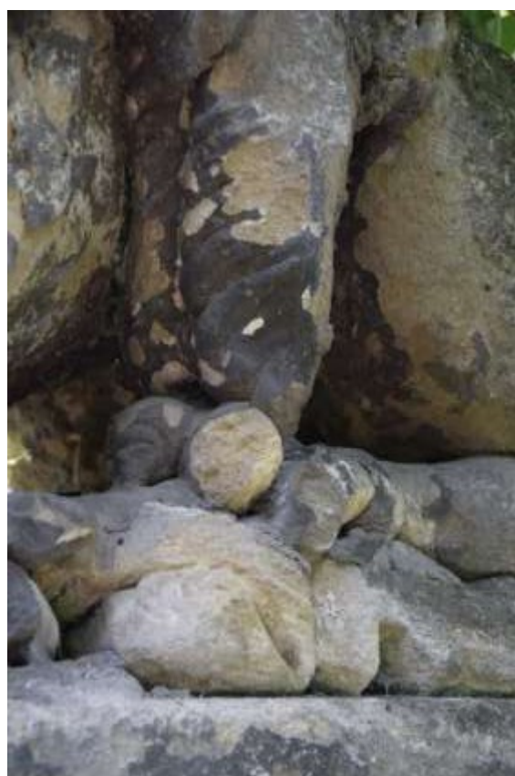
Griff (G2): Nagy plasztikai hiányok, kérgesedés, mállás
