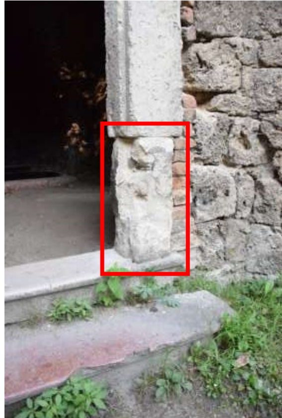
Nagy plasztikai hiányosságok az ajtó kőkeretén és lépcsőfokok profiljain. A kőkeret alsó része annyira rossz állapotú, hogy cseréje célszerű.
