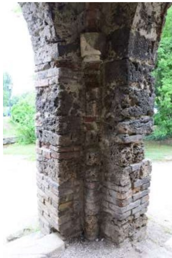
Elszürkült gipszesedett felületek a mészköveken és a fejezeteken
