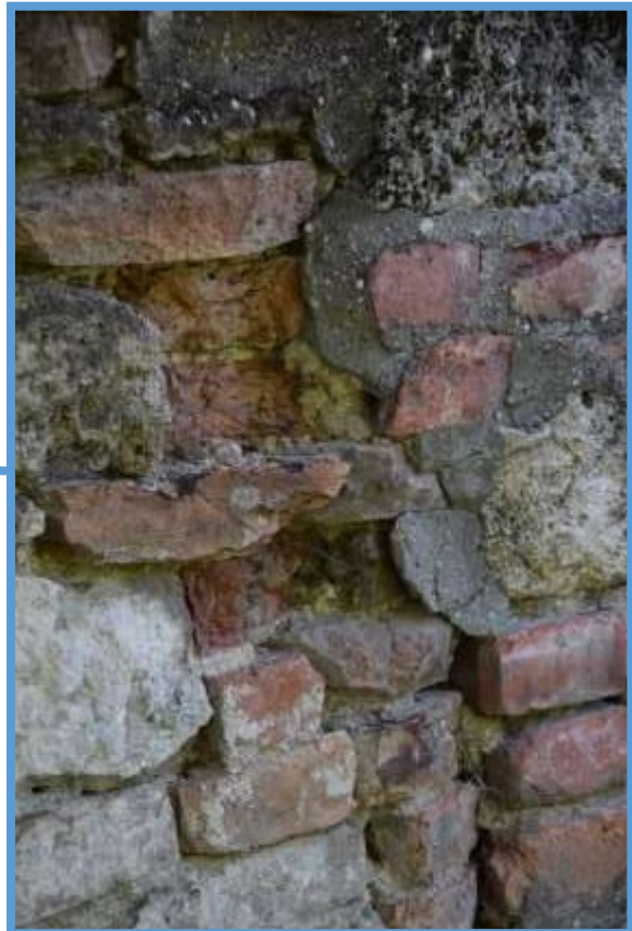
Hiányzó fugák és téglák, cementes megerősítések
