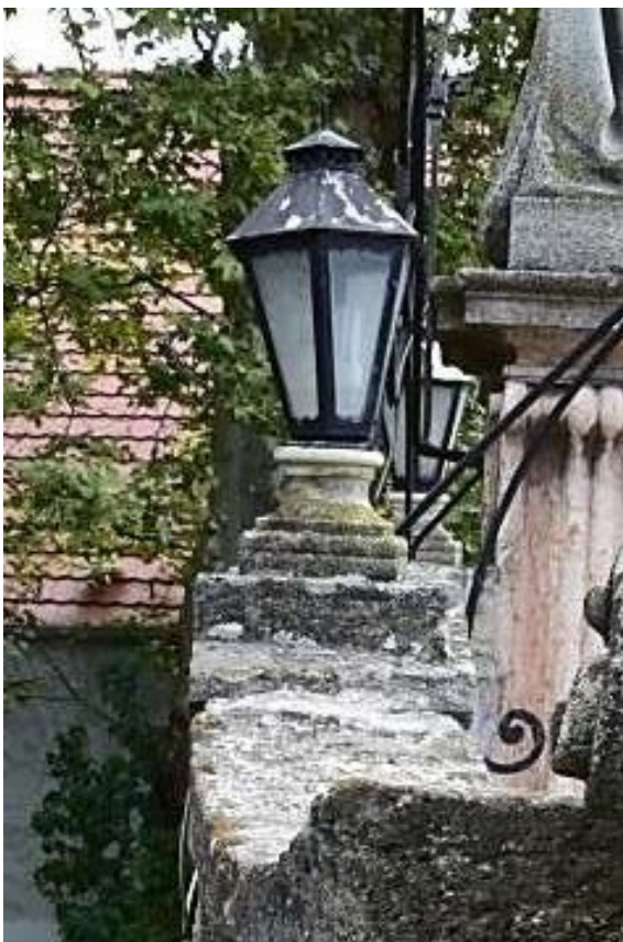
Plasztikai hiányok, hiányzó fuga, szennyezett felület.
