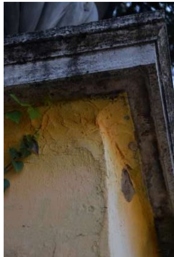
Felvált festékréteg a nedvesedéstől, málló vakolat, többszöri javítás nyomai
