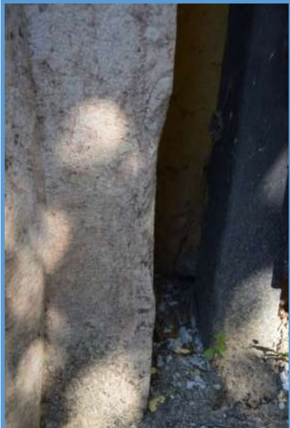
Plasztikai hiányok, friss stokkalás a kerékvetőn Bal oldali pillér
