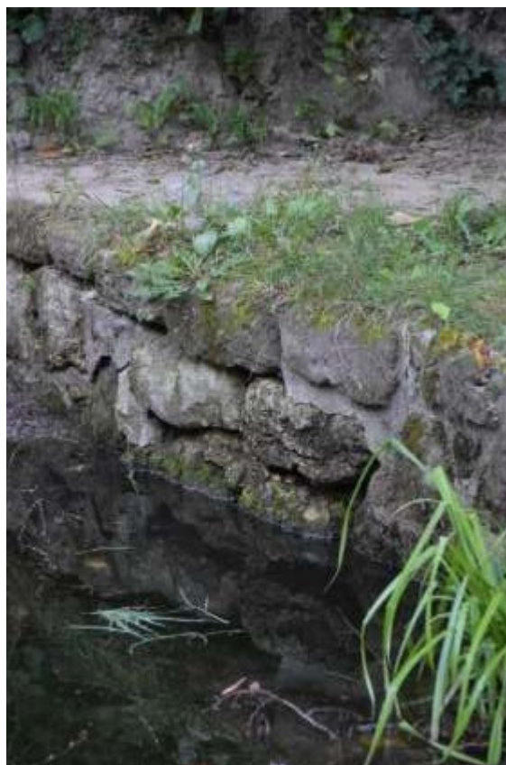
Erősen benőtt növényzet a patak hasábkövein, hiányzó kőelemek és fugák.
