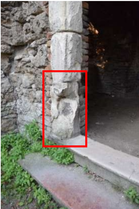
Nagy plasztikai hiányosságok az ajtó kőkeretén és lépcsőfokok profiljain. A kőkeret alsó része annyira rossz állapotú, hogy cseréje célszerű.
