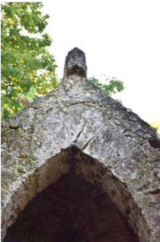
Körebepedt oromzati dísz, balesetveszélyes
