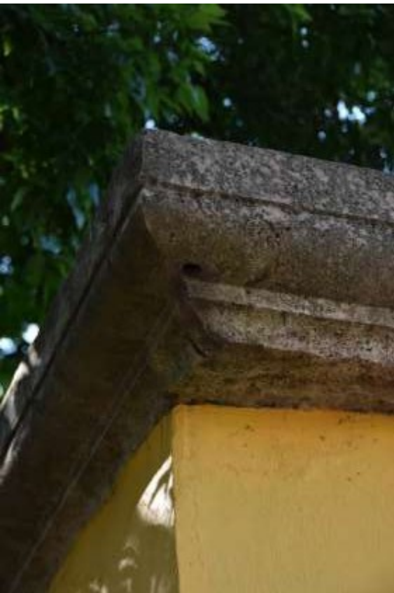
Plasztikai hiányok a fejezeten és a nedvesedéstől felvált festékréteg a törzsön Jobb oldali pillér
