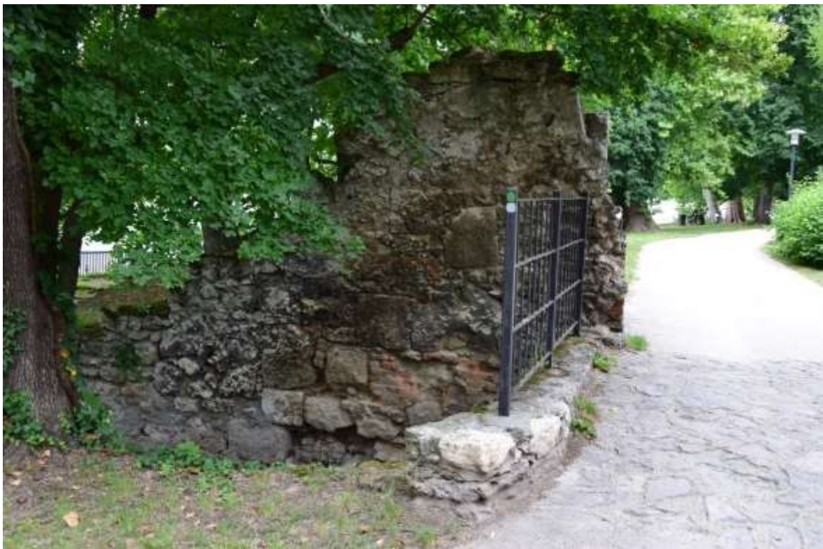
Vegyes falazat: hiányzó fugák, roncsolódott téglák, biológiai károsítók
