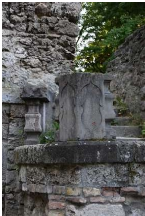
Tömött mészkő korlátelemek, szennyezett felületek, kő és téglahiányok
