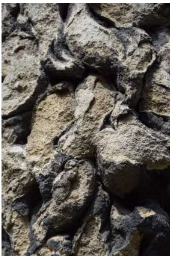
Griff (G2): Nagy plasztikai hiányok, kérgesedés, mállás
