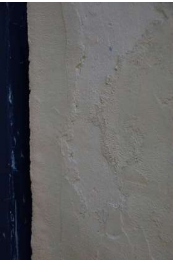
Felvált festékréteg a nedvesedéstől, málló vakolat, többszöri javítás nyomai
