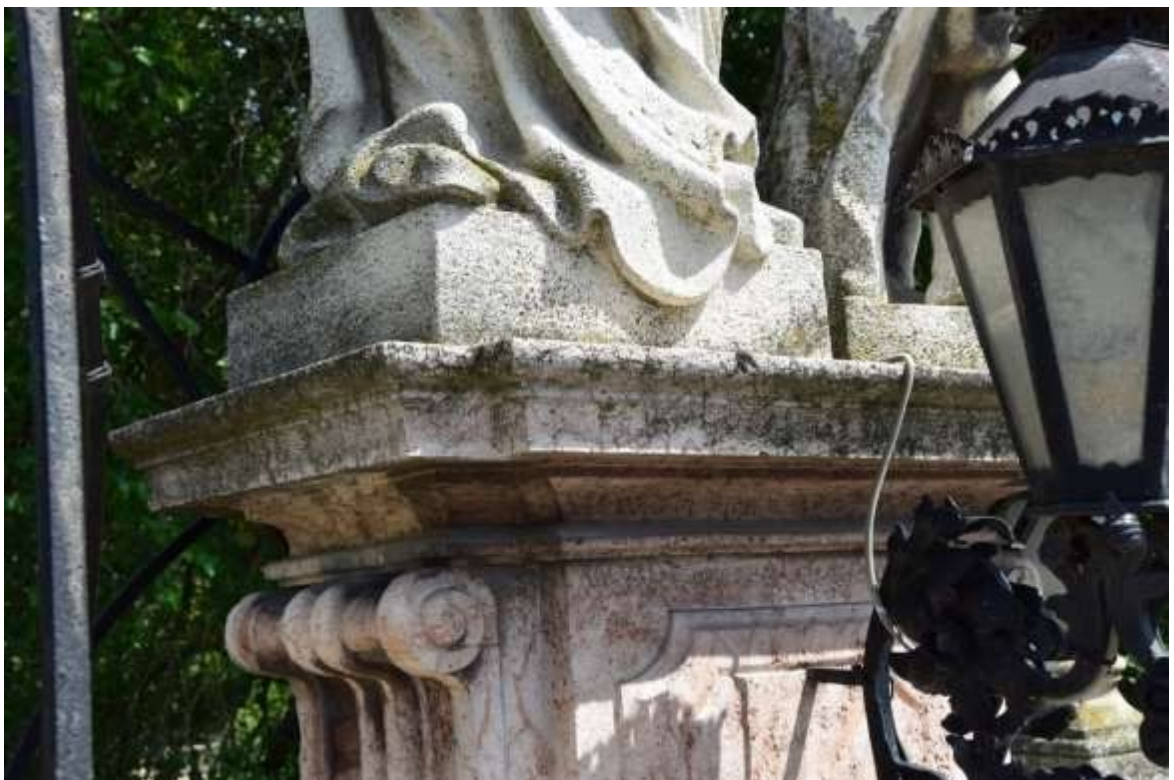
Biológiai károsítók megjelenése a plintoszon és a posztamensen.
