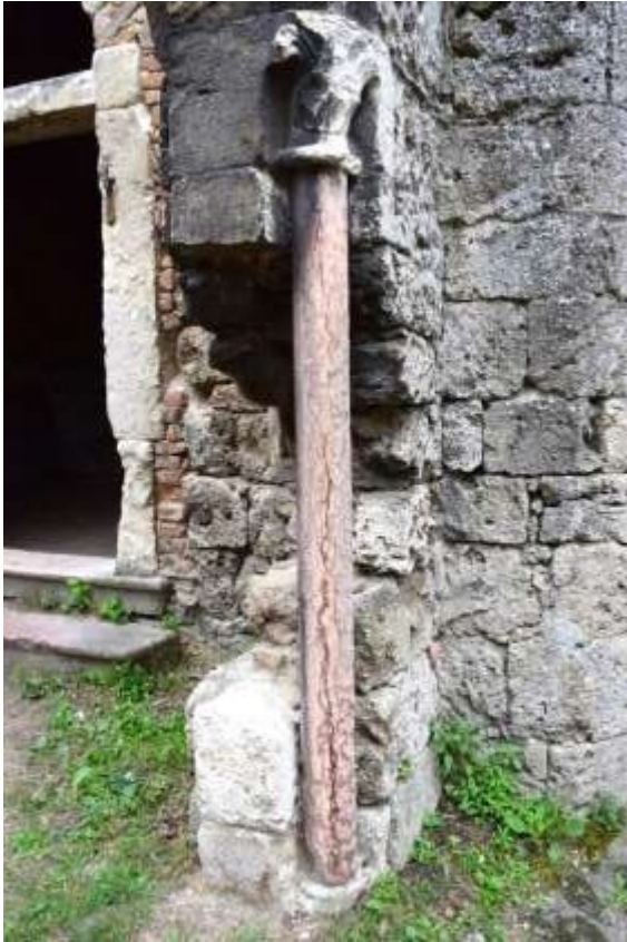
Vertikálisan megrepedt tömött mészkő oszlop.
