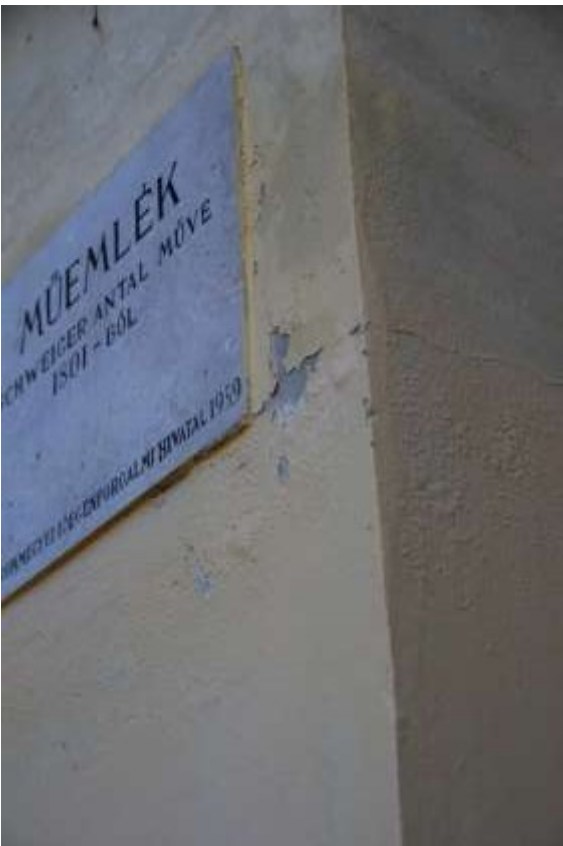
Felvált festékréteg a nedvesedéstől, málló vakolat
