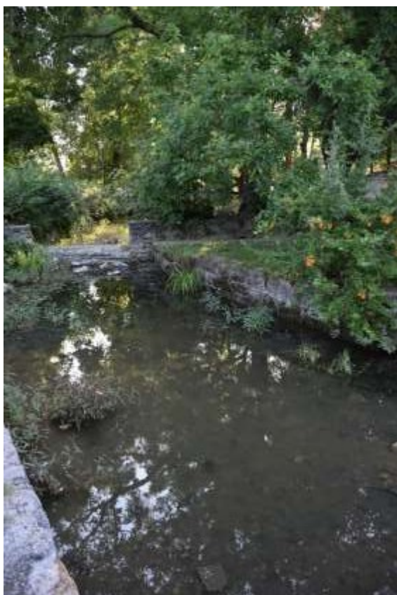
Erősen benőtt növényzet a patak hasábkövein, hiányzó kőelemek és fugák.
