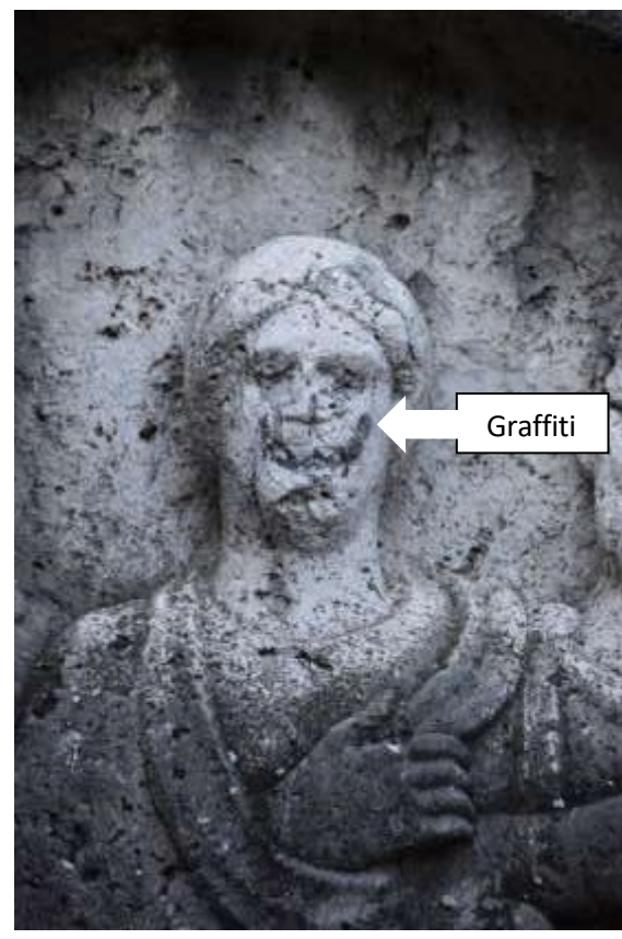
Szennyezett felületek és plasztikai hiányok a falazaton és a domborművön
