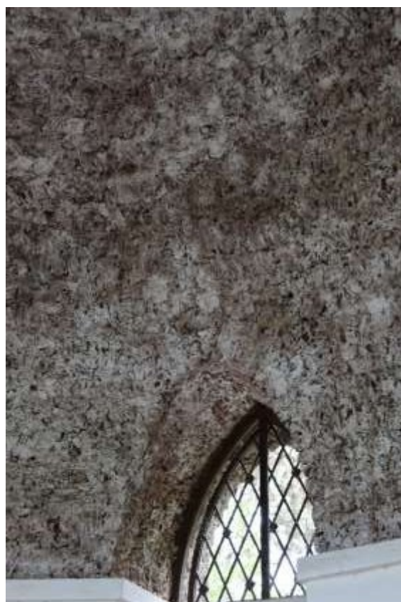
A beltér járőfelülete díszített mőkő, a falazat vakolt és festett, a mennyezet darázskő natúr megjelenésével.
