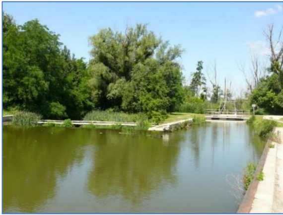
158. ábra: Által-éri szakasz korábban
