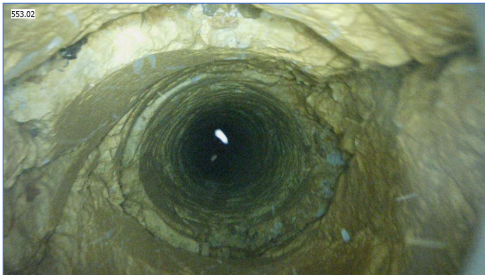
89. ábra: Repedések 553 m-ben a felső vízbeáramlási zónában
