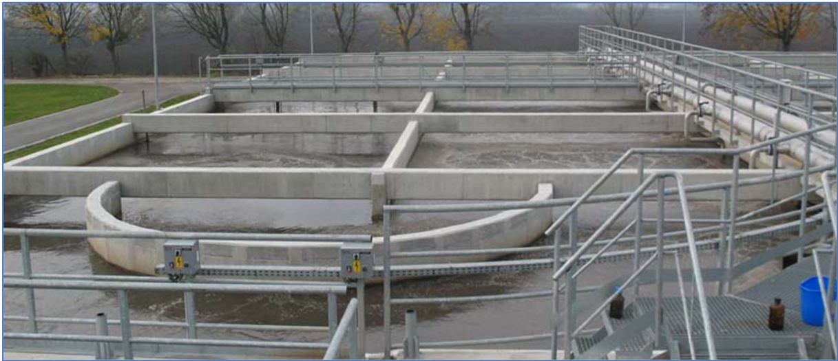
141. ábra: A rekonstrukciós munkálatok során épült biológiai medence
