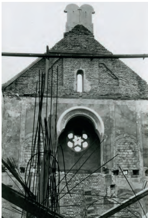
8. kép. A zsinagóga épülete átalakítás közben.
